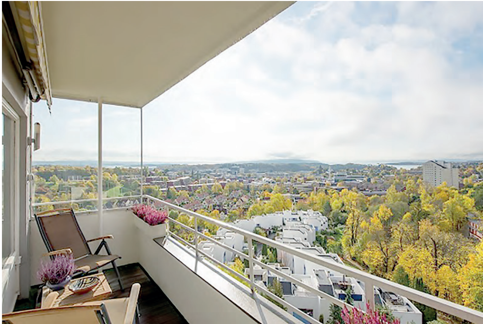
Reference bebyggelsen Gullkroken, Oslo
